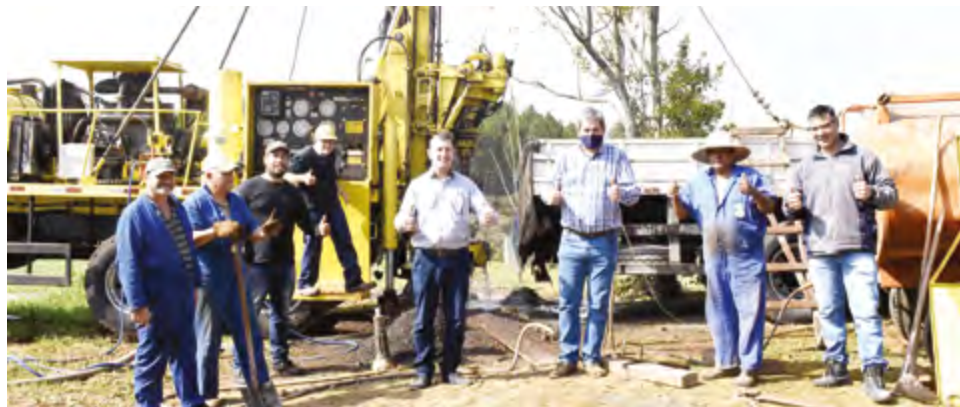
A unidade foi construída próximo ao Camping Tropical, à margem da rodovia ERS-126
