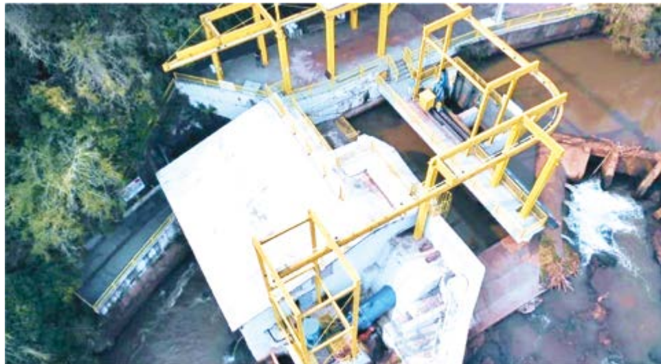
A Coprel ampliou a potência instalada na CGH
