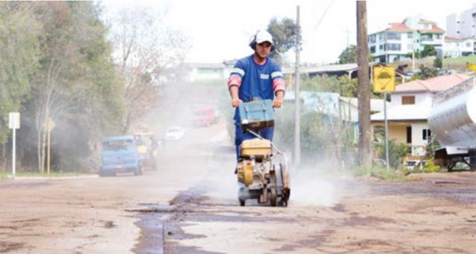
São aproximadamente dois quilômetros de nova tubulação
