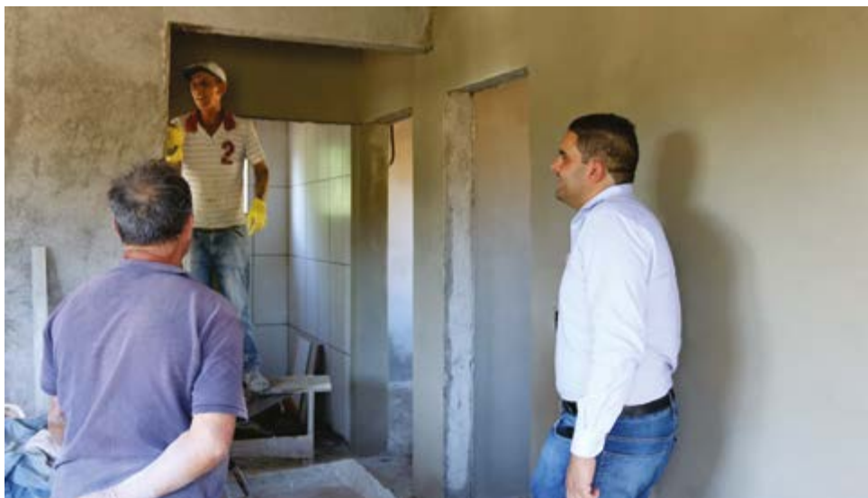
Prefeito Eduardo Picolotto tem visitado as obras em andamento
