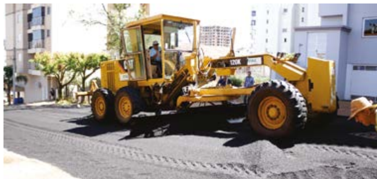
Melhorias com drenagem e cobertura em massa asfáltica
