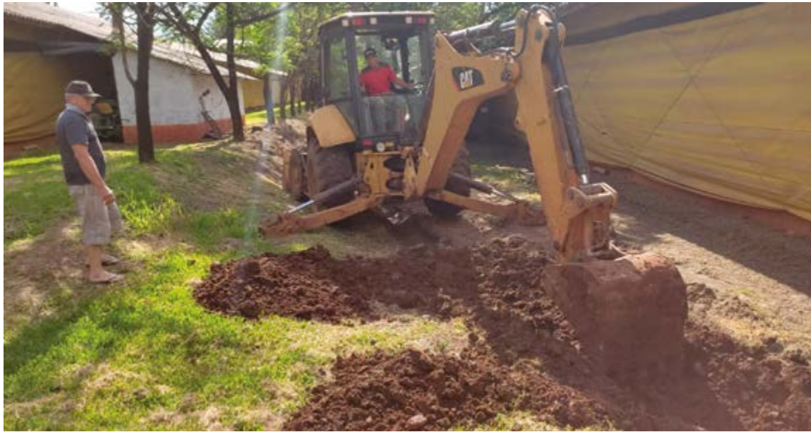
Abertura de valas para sistema de irrigação e foça séptica em propriedades rurais
