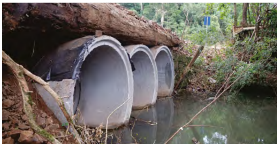
Tubos de concreto em substituição à antiga estrutura de madeira
