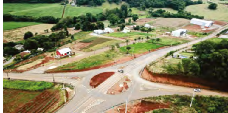
Execução dos trevos de entroncamento com ERS-463
