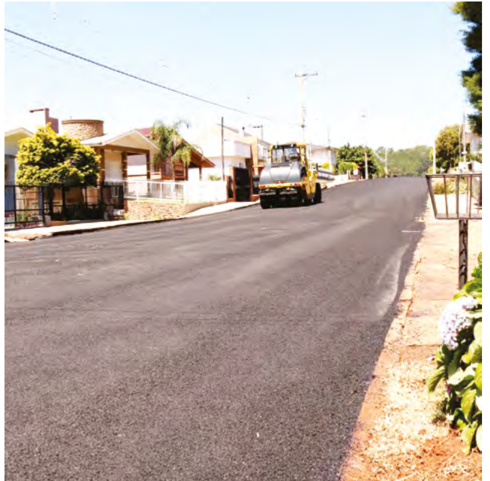
Essa é a primeira vez que é utilizado concreto betuminoso usinado a quente
