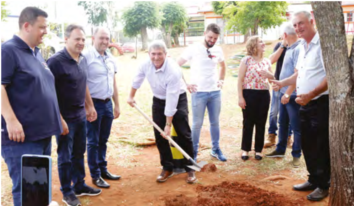
Em ato simbólico, prefeito Big marca início as obras de ampliação
