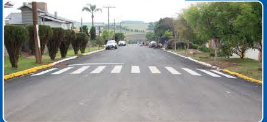
Pavimentação Asfáltica Rua Osório da Silveira
