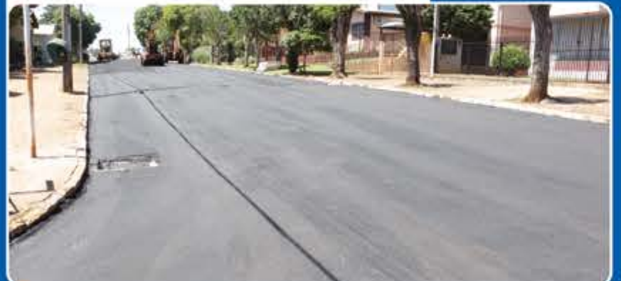
Pavimentação Asfáltica Rua Luiz Sitta
