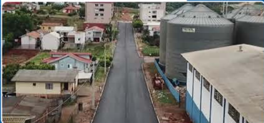
Pavimentação Asfáltica Rua Leorindo Cavichioli
