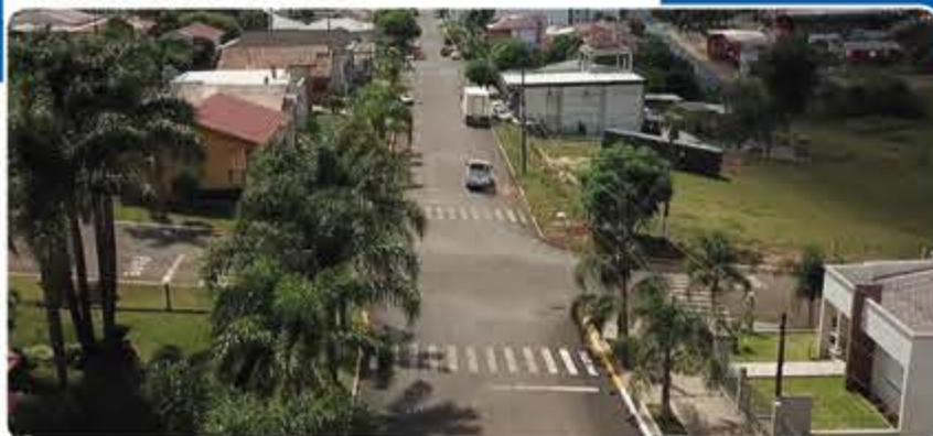
Pavimentação Asfáltica Rua Santo Canali
