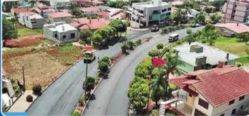
Pavimentação Asfáltica Avenida Valdo Nunes Vieira
