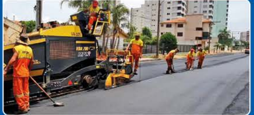
Pavimentação Asfáltica Avenida Eliseu Rech
