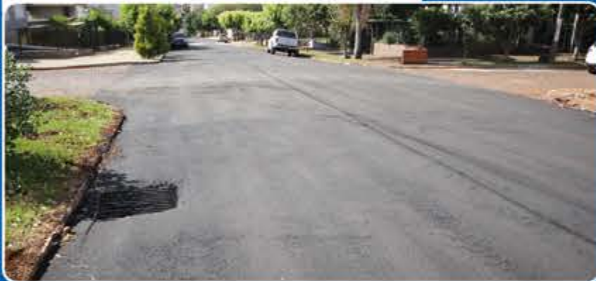
Pavimentação Asfáltica Rua Coronel Lólico
