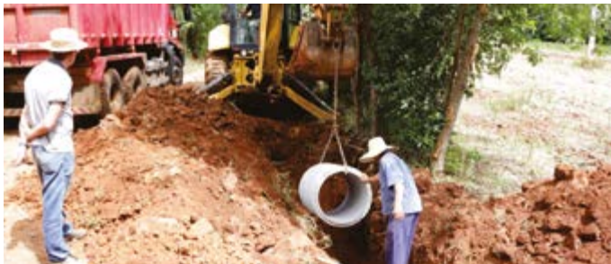
Foram colocados 120 tubos de concreto
