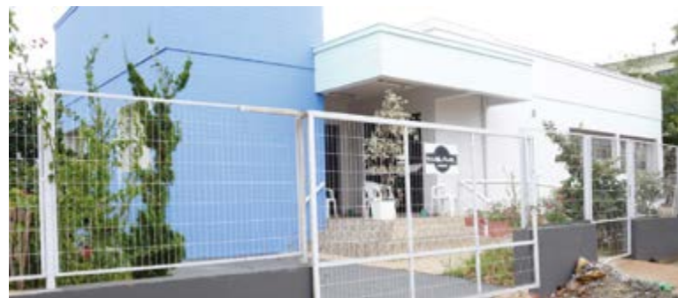
Troca do coberto, aberturas e pisos, toldos, corrimãos e pintura
