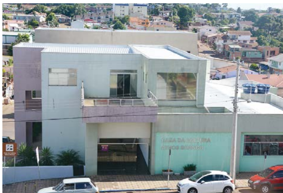
Avanço de mais uma etapa para o início das obras
