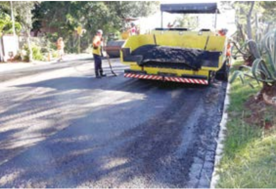
A obra é realizada através de parcerias
