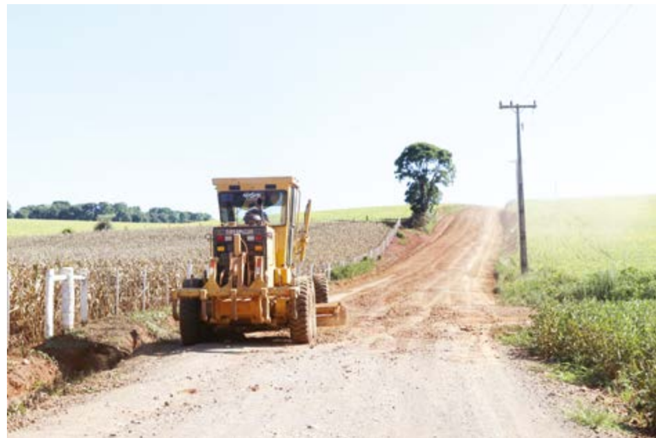
Melhorias em acessos à propriedades e terraplenagens
