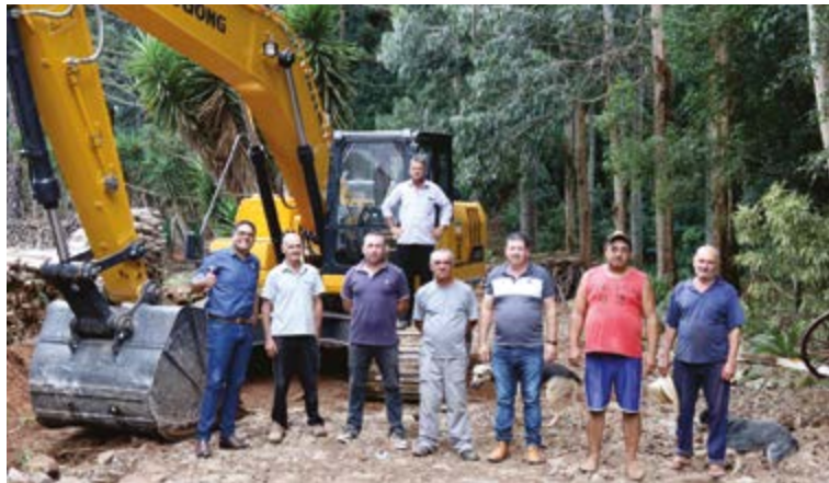
Secretaria de Obras entregou mais duas obras de substituição
