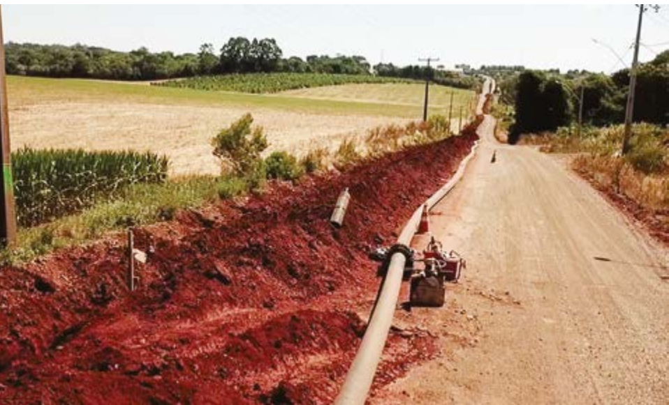
A ação foi realizada devido à instalação da rede de efluentes da empresa Italac
