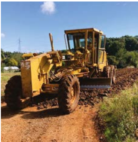
Serviços no acesso a propriedades
