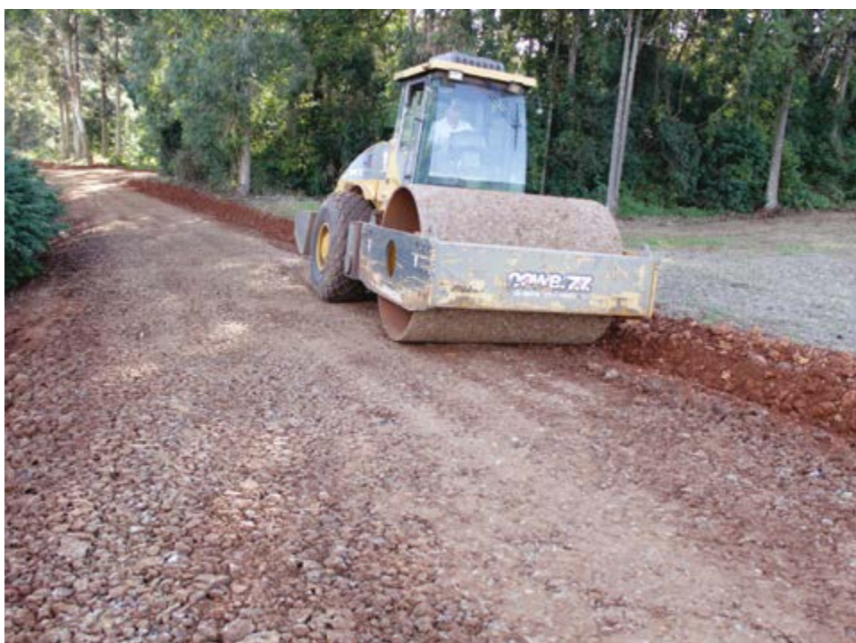
Patrolamento, cascalhamento e compactação
