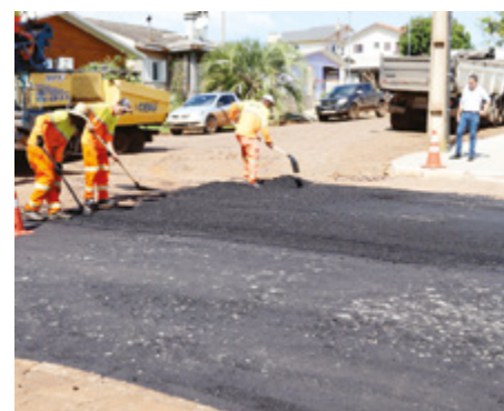
Prefeito acompanha as obras
