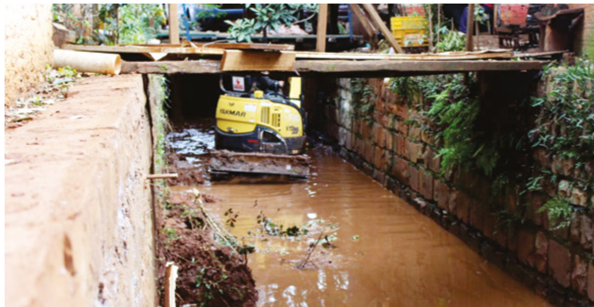
Limpeza realizada na parte aberta do rio
