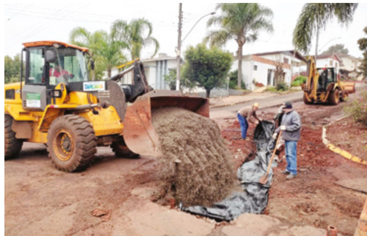
A obra terá investimento de aproximadamente R$180 mil
