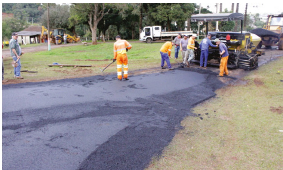
O asfalto quente é produzido pela Usina Asfáltica do Cirenor
