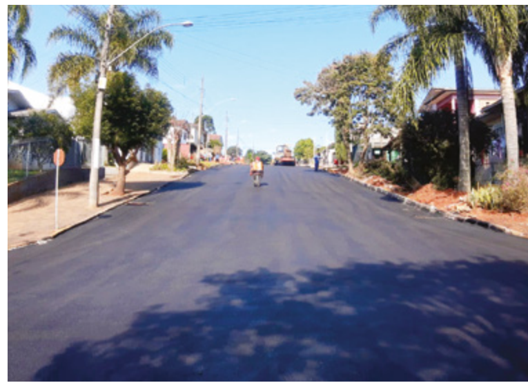
Rua Armando Annes também recebeu obras de asfaltamento
