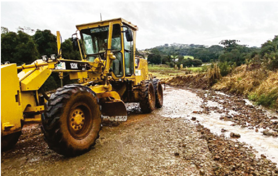
Secretaria de Obras realizou manutenção e recuperação destas estradas
