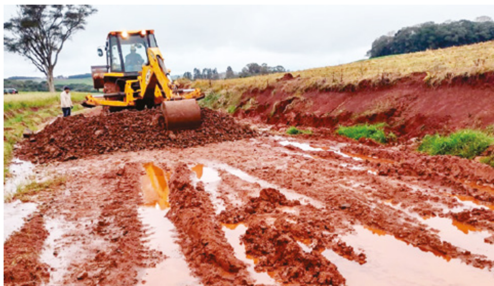
Foi realizado um trabalho emergencial e provisório
