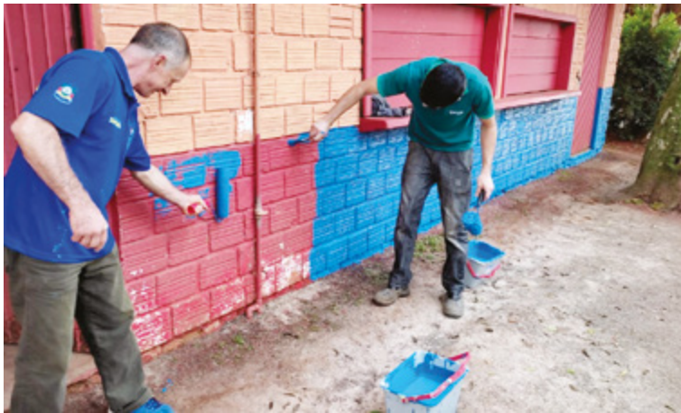
Melhorias ainda contemplam pinturas e sinalização
