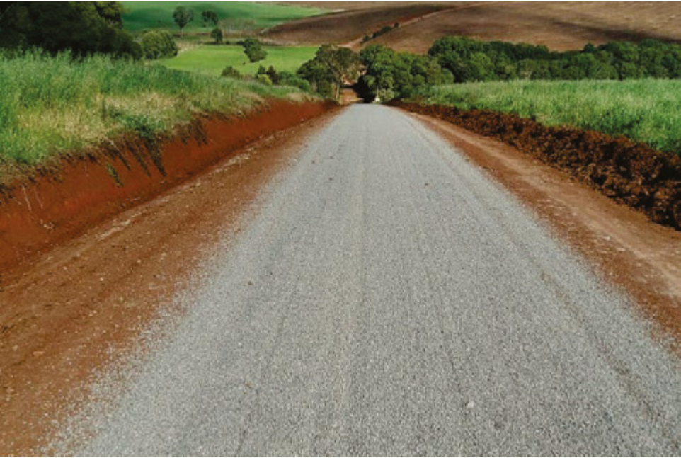
Reparos em estradas danificadas pelas chuvas
