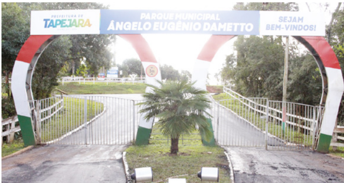
Entre as ações estão pavimentação, reformas e pinturas
