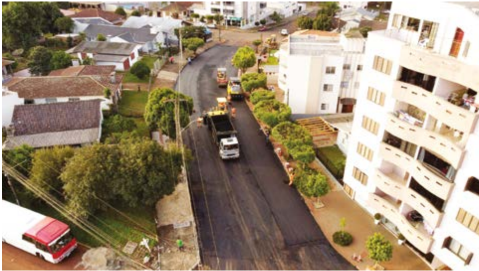
A obra totaliza 2.610,47 metros quadrados de asfaltamento
