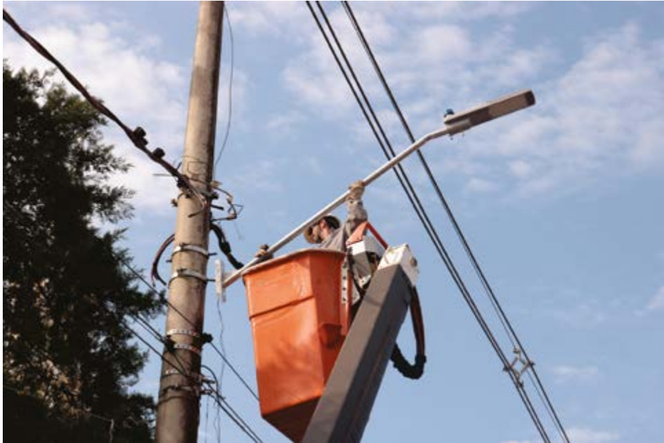
Substituição de 2.231 pontos das lâmpadas
