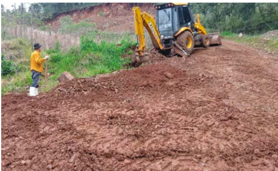
Compactação do solo de estradas
