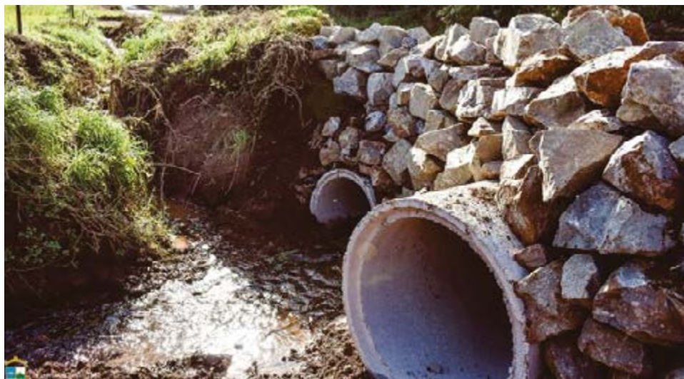
A obra foi realizada próximo à comunidade de Linha Campos
