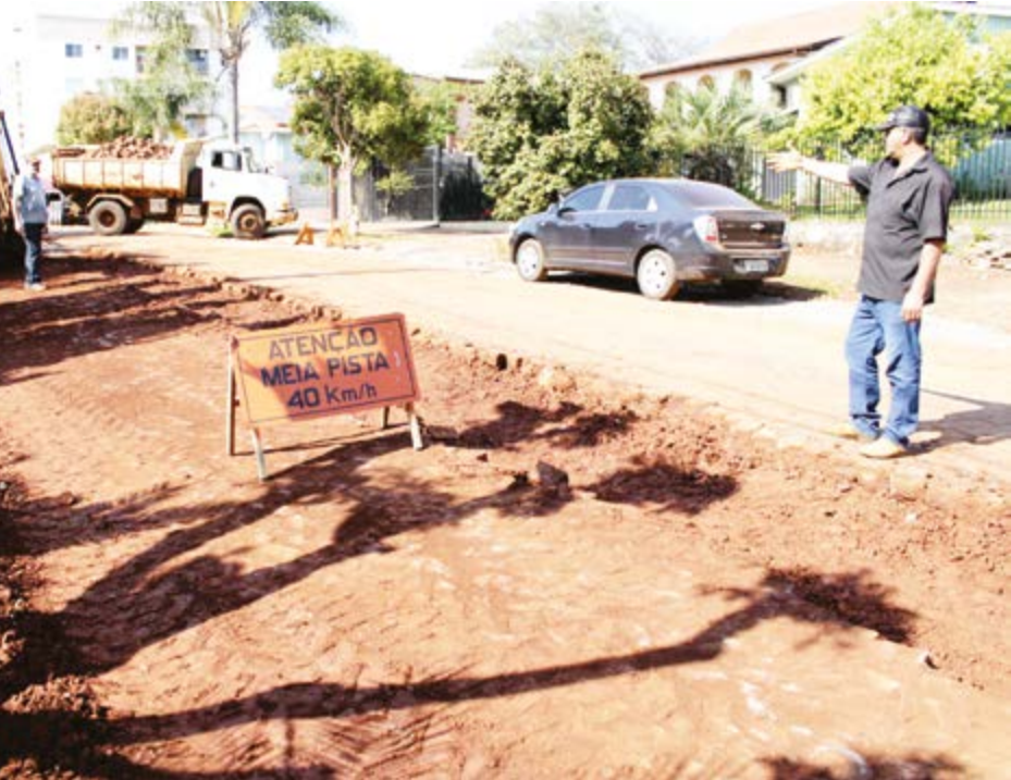
Obras de preparação para a pavimentação
