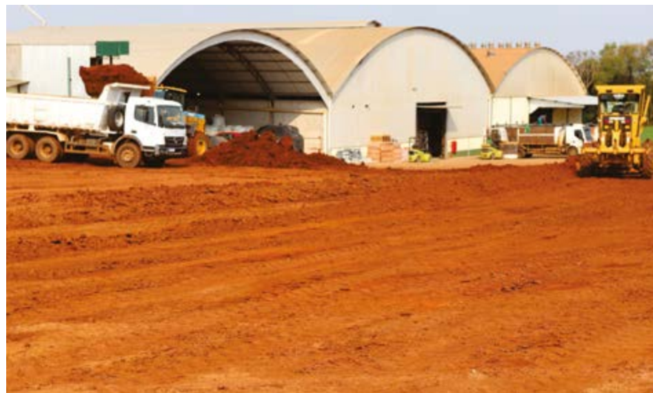
Melhorias em acessos às propriedades
