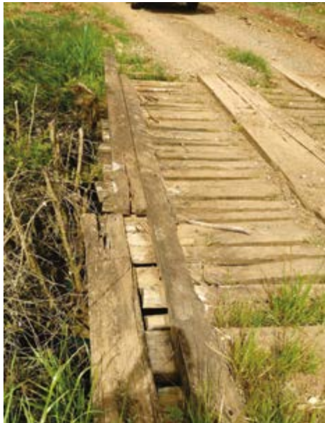
Antiga ponte de madeira
