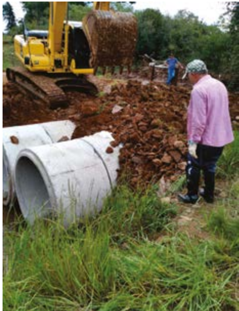
Ponte construída com tubos de concreto
