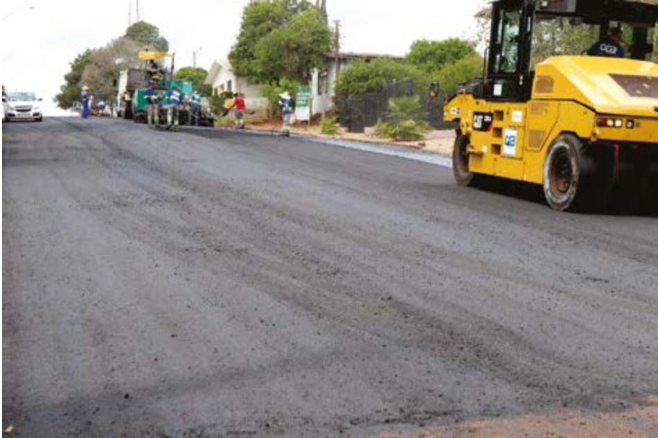
A obra teve um investimento de R$ 312.690,90
