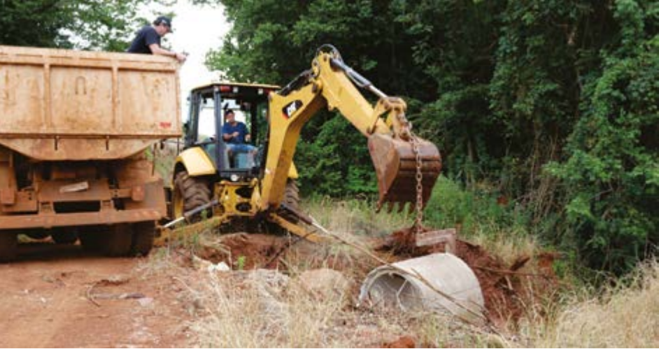
Colocação de tubos em algumas estradas
