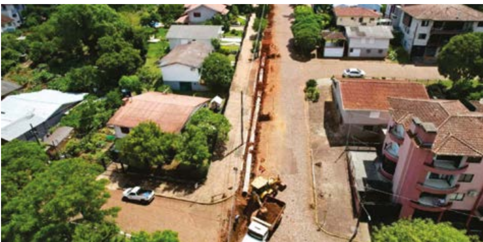
Instalação da rede pluvial com o objetivo de melhorar o escoamento da água
