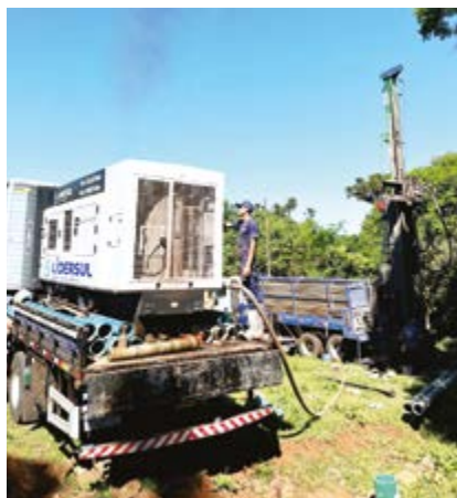
Perfuração de poço
