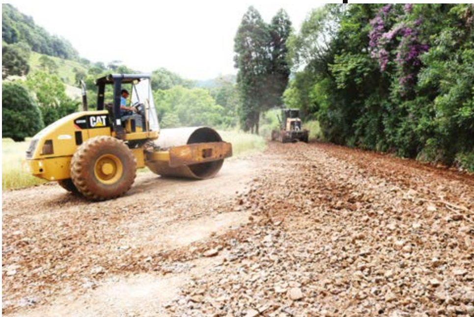
Foram feitos serviços de britagem e compactação do solo
