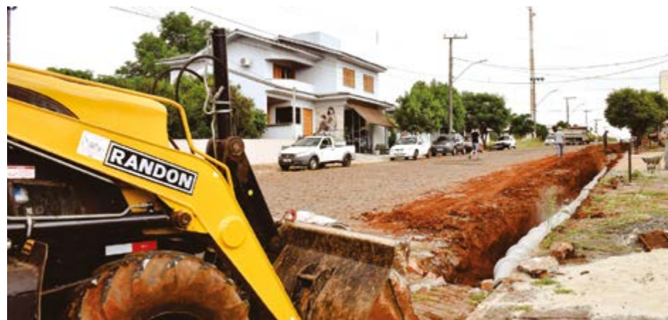
Foi feita a troca e ampliação da rede pluvial
