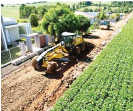
Cascalhamento e regulação de solo
