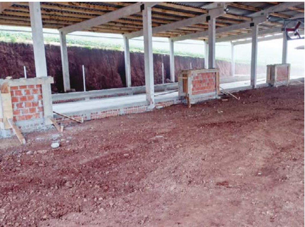
No local, foi utilizado o serviço de retroescavadeira
