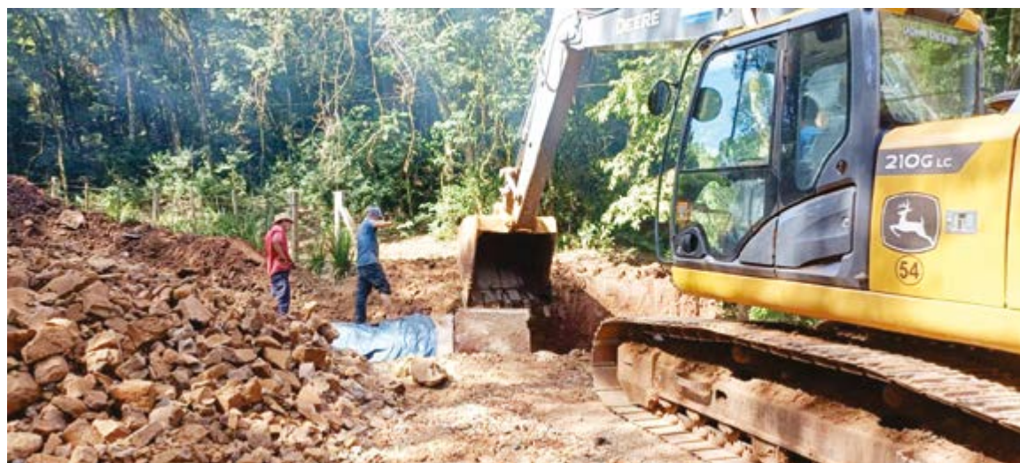
Foram instalados 14 tubos de 1,5m de diâmetro
