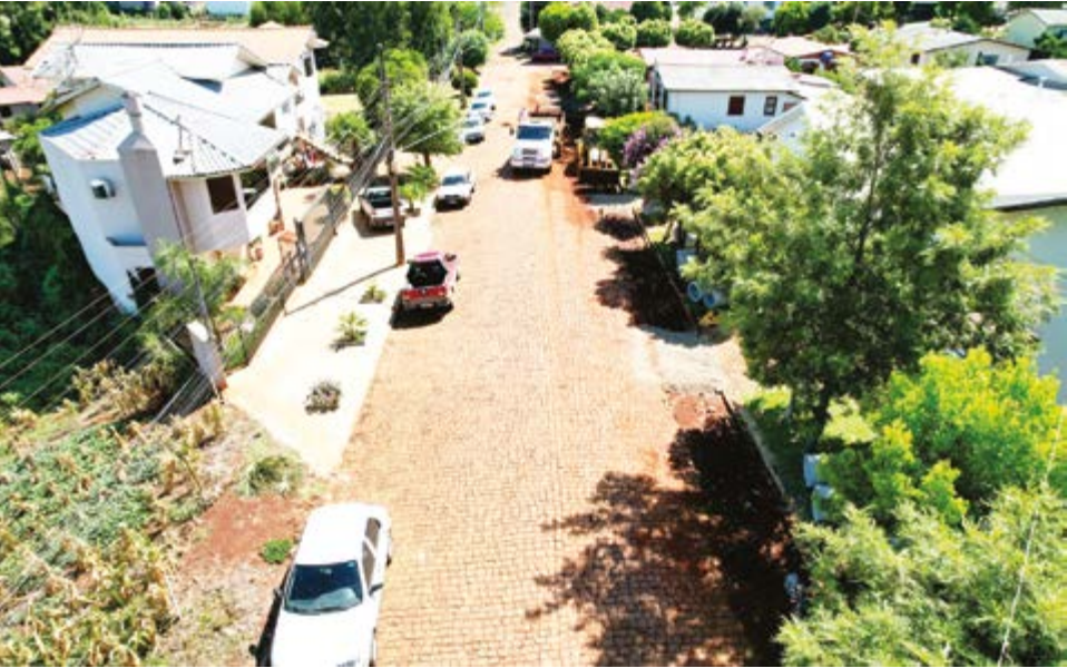
Primeiro passo com o trabalho da rede pluvial
