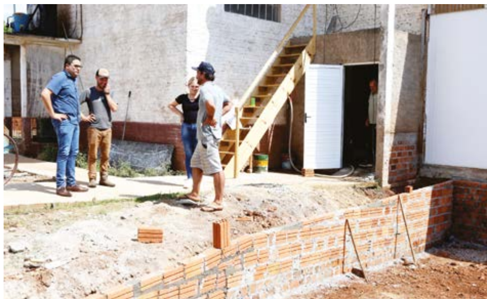
Prefeito Eduardo acompanha obras que estão sendo executadas
