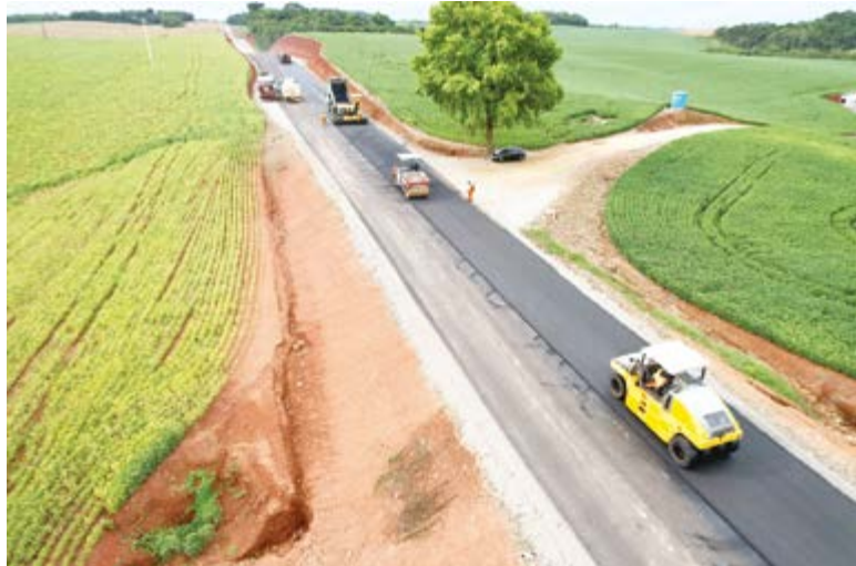
A estrada está sendo pavimentada através de uma ampla mobilização
