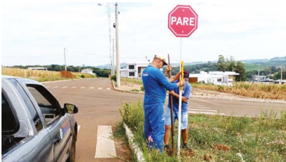
A sinalização vertical utiliza materiais mais duráveis e resistentes
