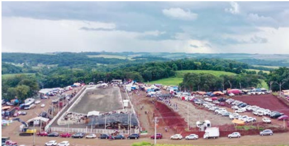
Parque construído pela prefeitura está instalado numa área de cinco hectares
