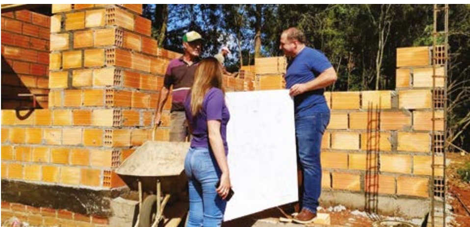
Prefeito João e engenheira Regina estiveram na obra
