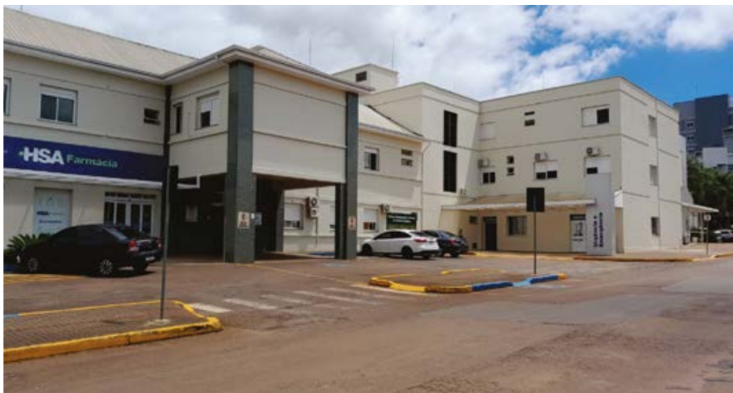
A execução da pintura externa conclui o ciclo de reformas na estrutura física
