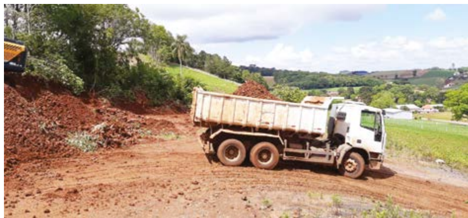
Foram realizadas 808 intervenções em estradas
