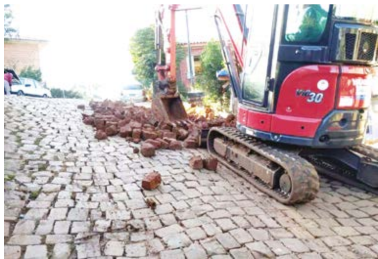
Nova pavimentação com paralelepípedo
