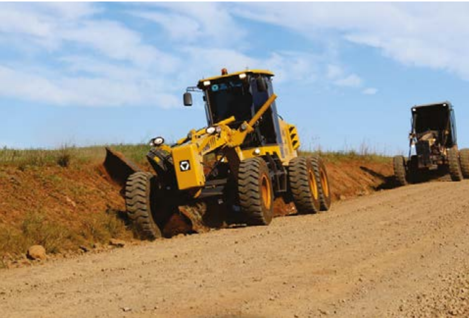
Trabalhos ficaram voltados para a estrada geral da que dá acesso à Comunidade
