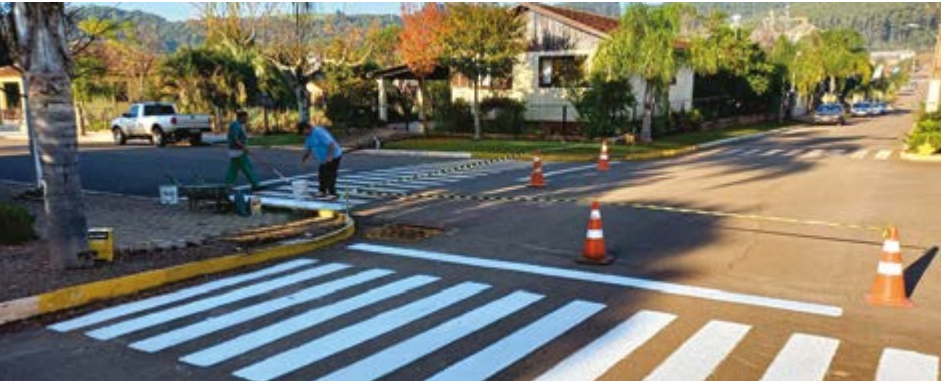
Rua do centro recebem pintura
