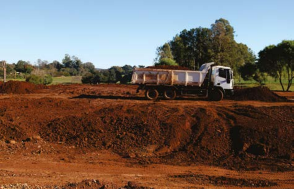
Execução de escavações, aterros, terraplenagem
