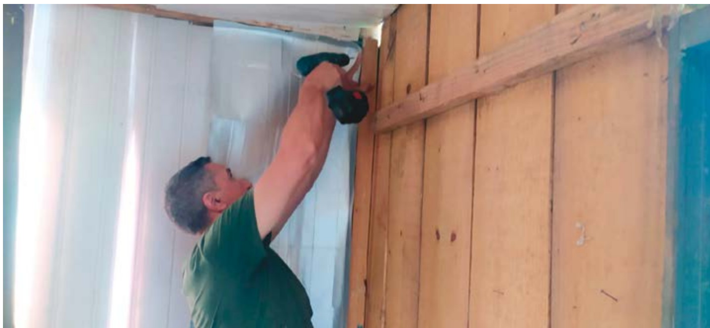
Caixas de leite são transformadas em placas isolantes térmicas para proteção contra o frio e umidade. PÁGINA 12
