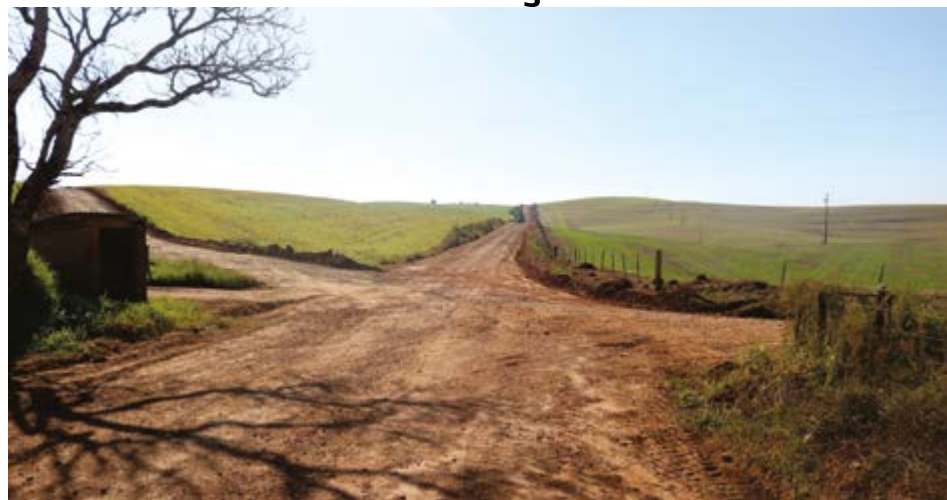
Reparação em 25 acessos a propriedades rurais
