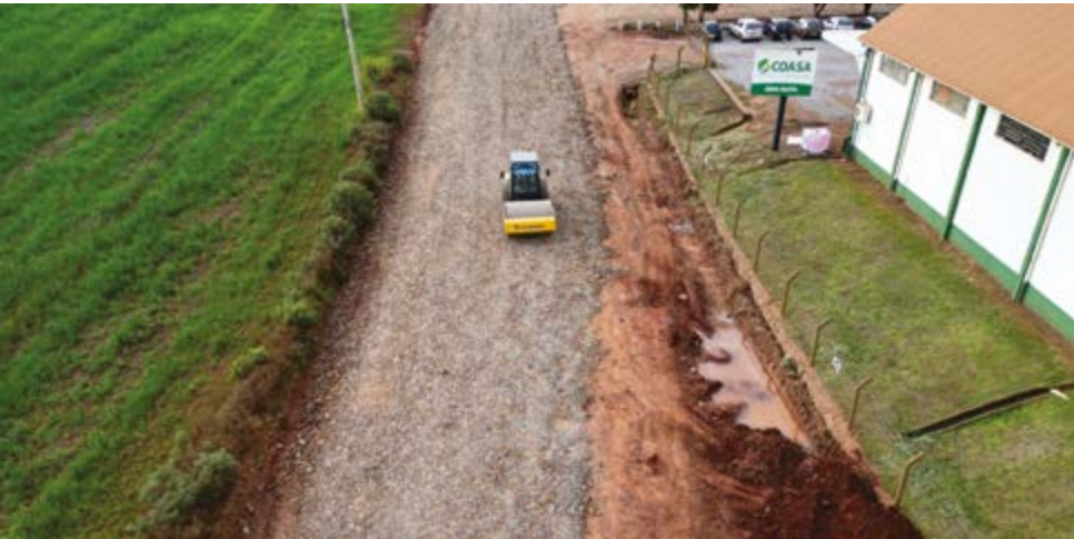
Serviços de patrolamento, cascalhamento e compactação na ERS-428
