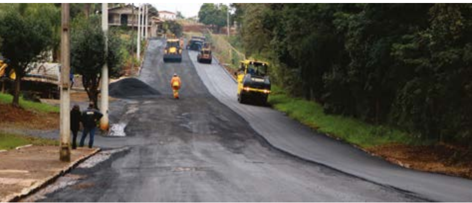
A execução dos trabalhos compreende um total de 2.475 m²
