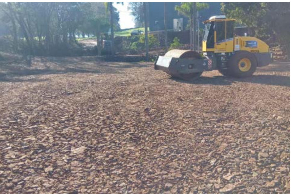
Manutenção e recuperação de estradas públicas
