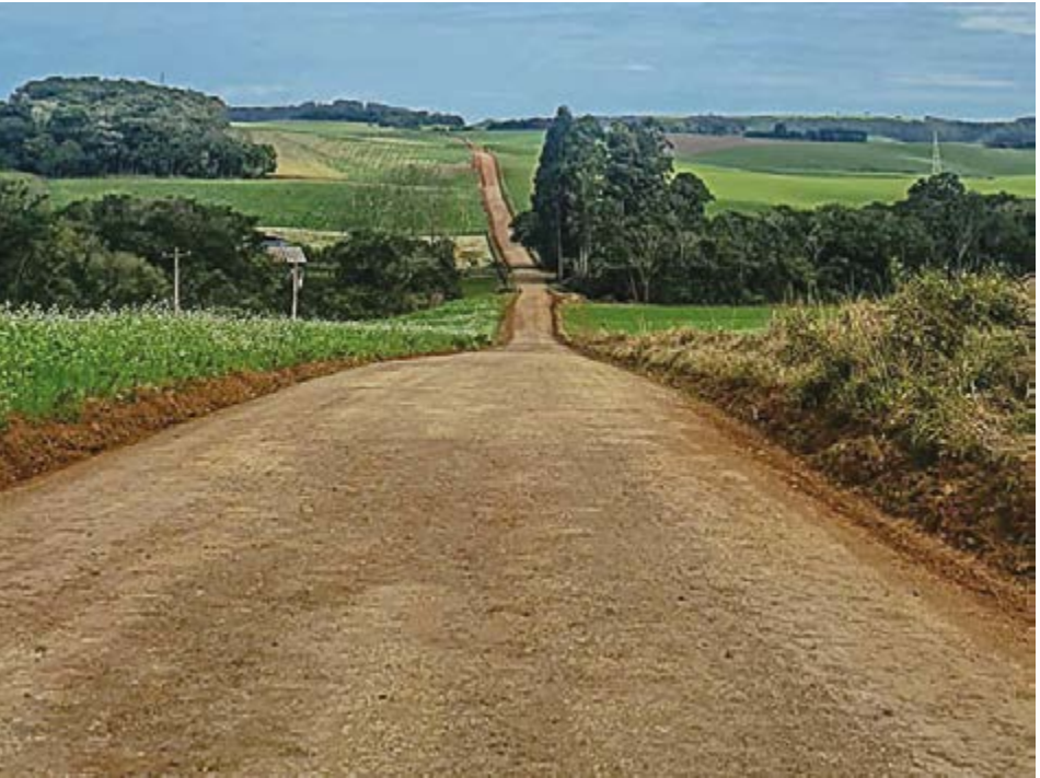
Foram realizados serviços de patrolamento, compactação e colocação de brita
