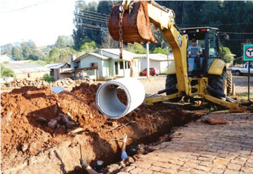
Tubulação da rua Miguel Moro
