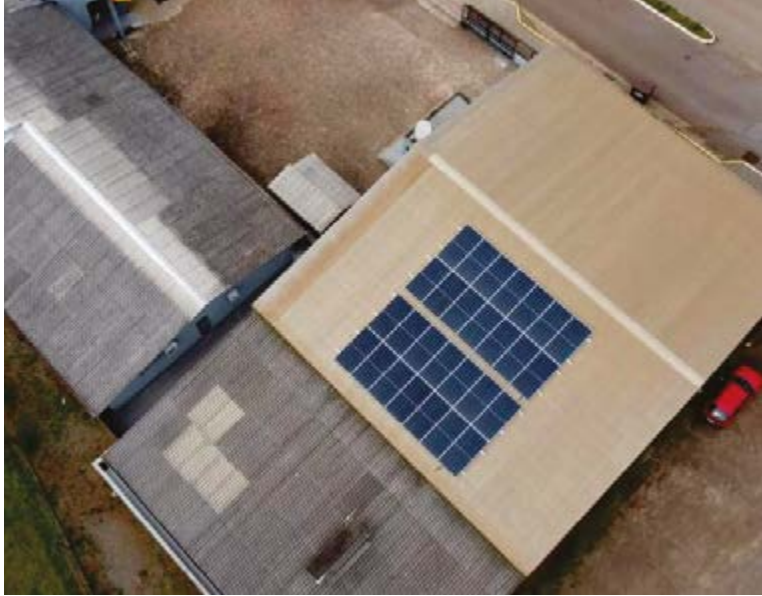
São 216 painéis fotovoltaicos que capturam os raios solares
