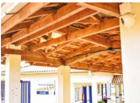
Foram instaladas 10 câmeras
